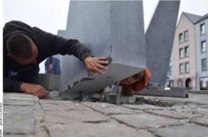
La fixation a été réalisée par scellement chimique sur des tiges en inoxydable.
